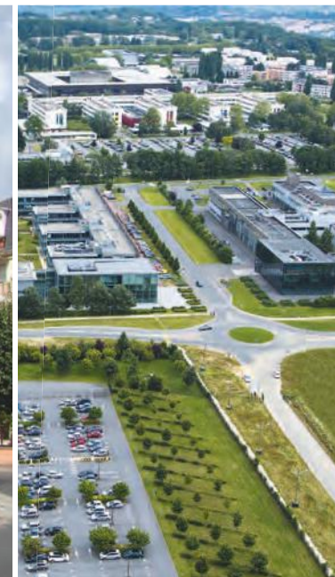
Pôle tertiaire à Noisy-le-Grand
